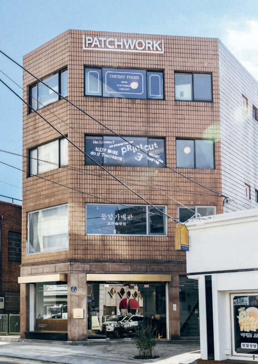
1 4층짜리 건물을 통째로 사용하는 패치워크. 다양한 문화예술 프로젝트와 지역 축제를 열어 낯선 여행객들을 배다리로 안내한다. 2 세모난 지붕에 동그란 창문, 붉은 벽돌 굴뚝까지 독특한 외관의 인천 구 여선교사 합숙소는 동화 속 집을 떠올리게 한다. 3 영화초등학교 본관동 창문 아래 톱니 모양 벽돌들은 장식용이면서 빗물을 막아 주기도 한다.
